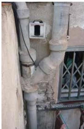
Figura 6. Conexión de bajantes de fibrocemento a uno de PVC.
