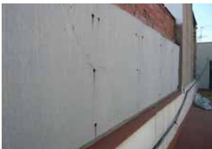
Figura 5. Placas lisas de fibrocemento atornilladas a madera.
