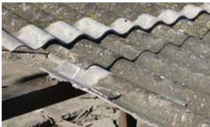
Figura 4. Placas onduladas de fibrocemento atornilladas a madera.
